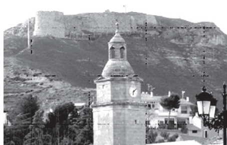
Cubo y muralla de la fortaleza
